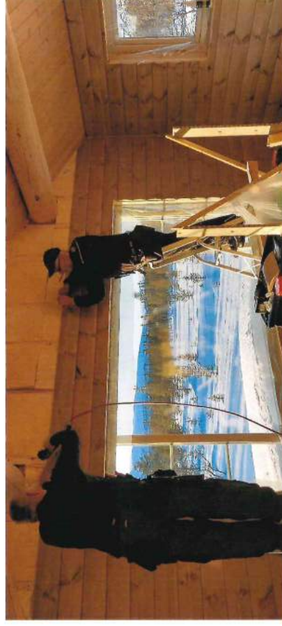
Jan Egil Kveen og Kjell Håvard Skogheim legger stokkpanel i stue på Røsetra
